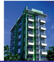
Konut / Property Bangladeş / Bangladesh Maati Emlak Site Projesi Maati Property Site Project Adet /Piece - Güç /Power : 1 x 274kVA
