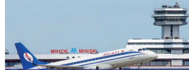
Havalimanı / Airport Belarus / Belarus Minsk Havalimanı Minsk Airport Adet /Piece - Güç /Power : 4 x 700kVA
