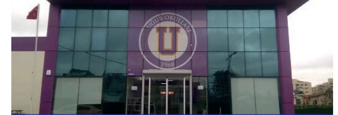
Eğitim / Education Türkiye / Turkey Uğur Okulları Ugur Schools Adet /Piece - Güç /Power : 12 x 400kVA-440kVA
