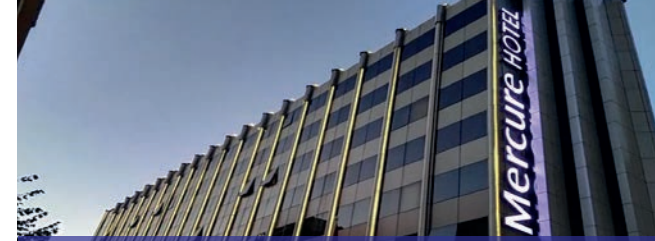
Otel / Hotel Türkiye / Turkey Mercure Otel - Trabzon Mercure Hotel - Trabzon Adet /Piece - Güç /Power : 1 x 1010kVA
